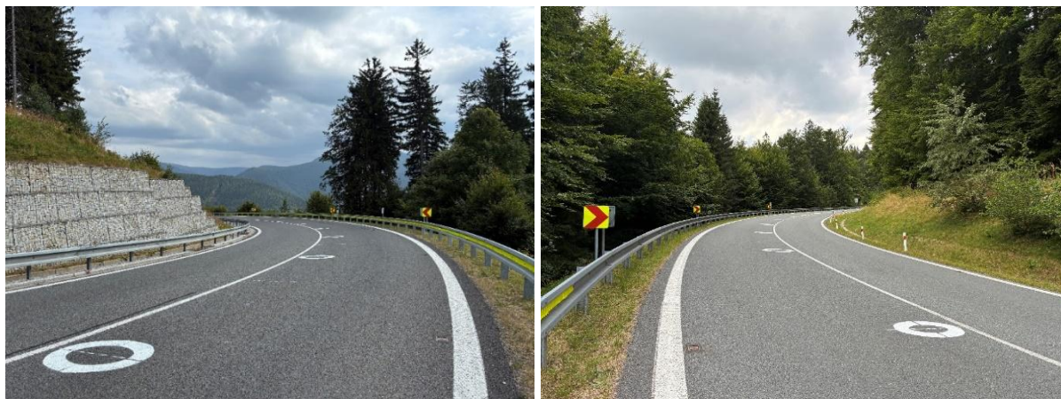
Obrázek 33 Vodorovné dopravní značení ve směrovém oblouku (I/44 poblíž Červenohorského sedla)
